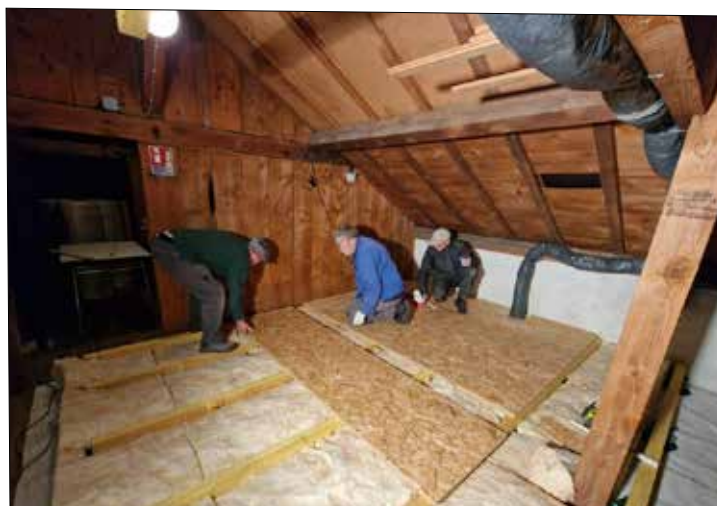
La pose de l'isolation du plancher au grenier entièrement réalisée par nos membres bénévoles. Merci à l'équipe !
